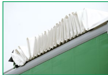
Geöffnetes Verdeck Open roof
